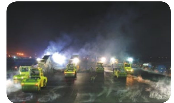
场道工程 - 沥青混凝土摊铺
